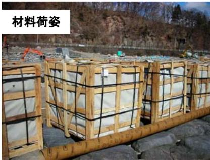
現場には、1ケースが1m四方で約1.5t程度のものが、1コンテナで10ケース届きます。EKウォール製品面積は約12.15㎡/1ケース
