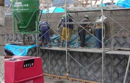
EKウォールと堤体の溶接取付け状況
