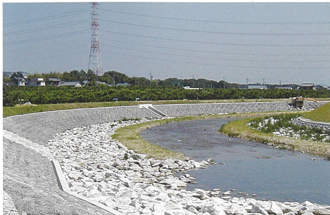
ロックボードR 愛知県 籠川(施工直後)
