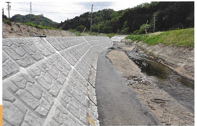
ロックボードW 愛知県 摺子川
