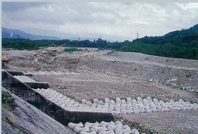
長野県 大町建設事務所 高瀬川6ton 根固・水制工
