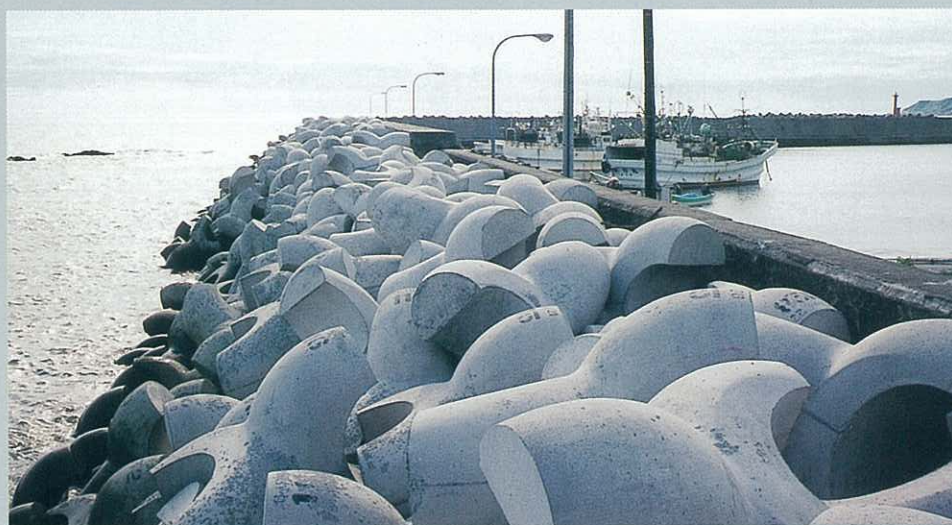
北海道 室蘭土木現業所 東静内漁港4ton 消波工
