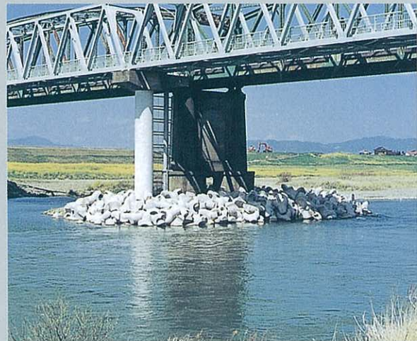
福岡県 久留米土木事務所 筑後川2ton 橋脚根固工
