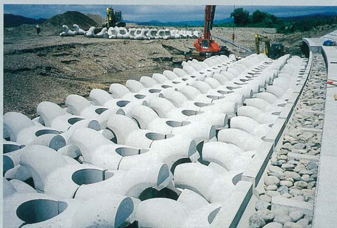
北陸地方整備局 阿賀川工事事務所 阿賀川3ton 根固工
