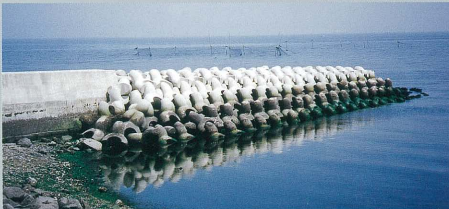
愛知県 豊橋土木事務所 田原海岸2ton 突堤(2層被覆)
