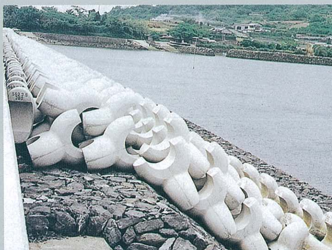
九州農政局 出水海岸保全事業所 出水海岸3ton 消波工
