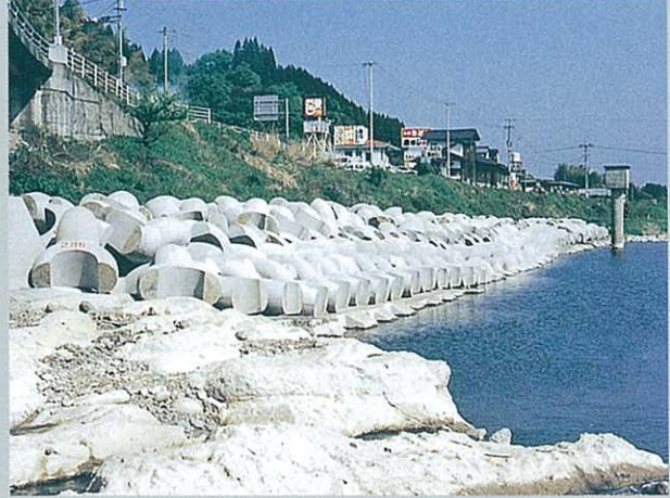
大分県 玖珠土木事務所 玖珠川8ton 根固工
