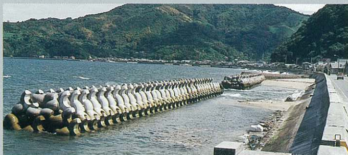
山口県 東和町役場 和田漁港4ton 離岸堤
