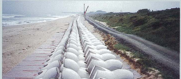
茨城県 高萩土木事務所 下桜井海岸4ton 消波堤
