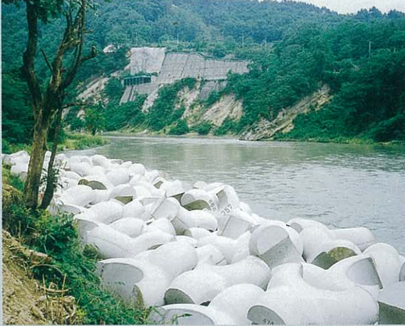
長野県 長野建設事務所 犀川3ton 根固工
