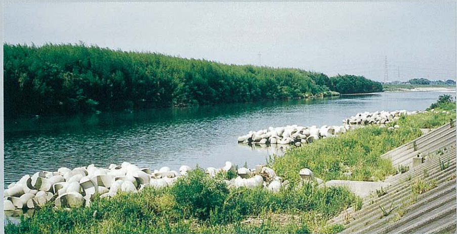
中部地方整備局 豊橋工事事務所 豊川2ton 水制工
