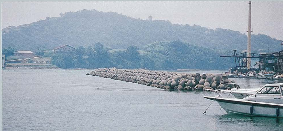
岡山県 岡山地方振興局 牛窓港2ton 離岸堤(2層被覆)
