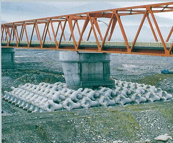
長野県 飯田建設事務所 天竜川6ton 橋脚根固工
