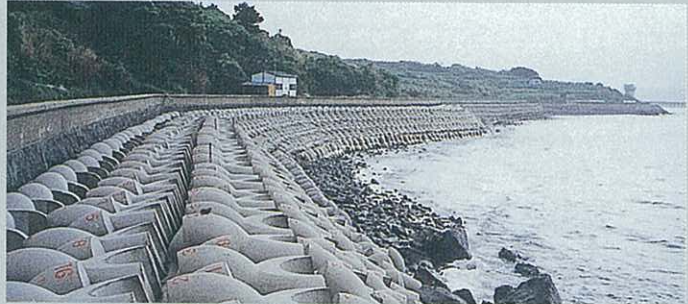
長崎県 県北振興局 早崎海岸2ton 消波工
