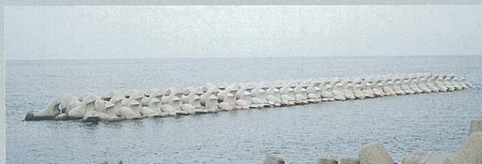
北陸地方整備局 黒部工事事務所 目川海岸20ton 離岸堤
