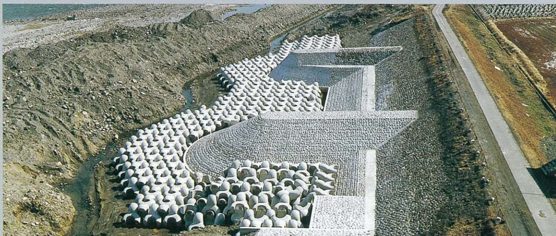
関東地方整備局 甲府工事事務所 釜無川6ton 水制工
