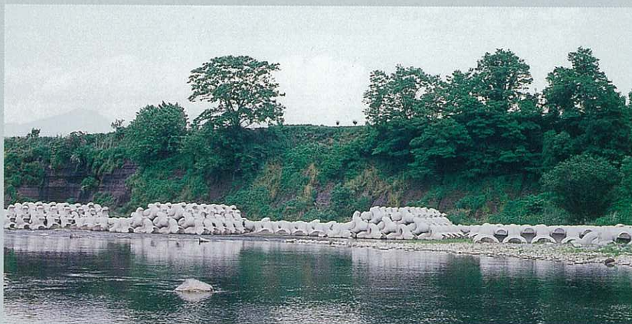
長野県 佐久建設事務所 千曲川8ton 根固・水制工
