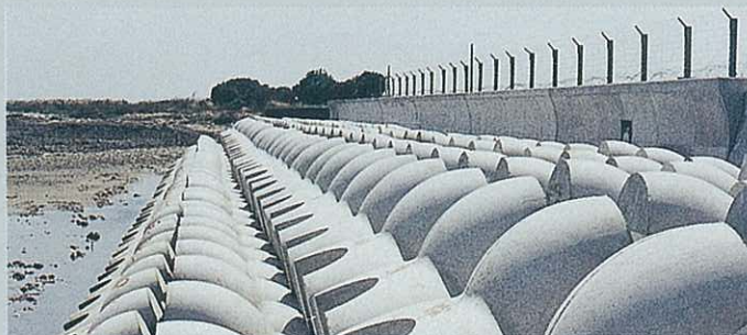
福岡県 行橋土木事務所 稲童海岸3ton 消波工
