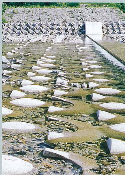
北陸地方整備局 松本砂防工事事務所 平川3ton 護床工
