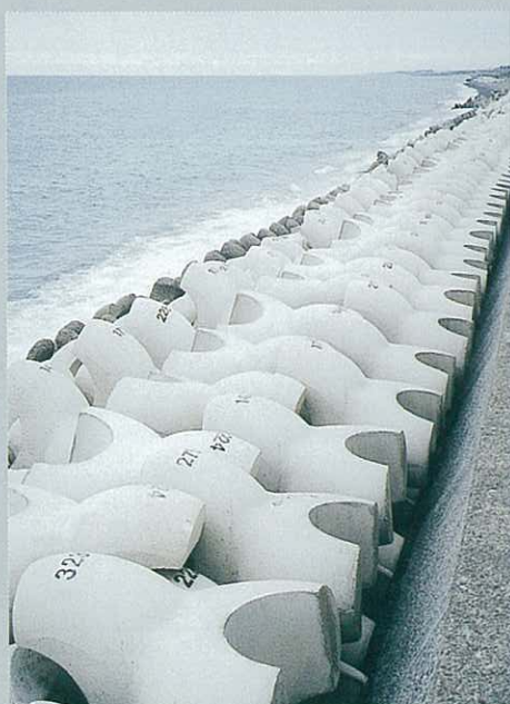
石川県 小松土木事務所 小松海岸6ton 消波工
