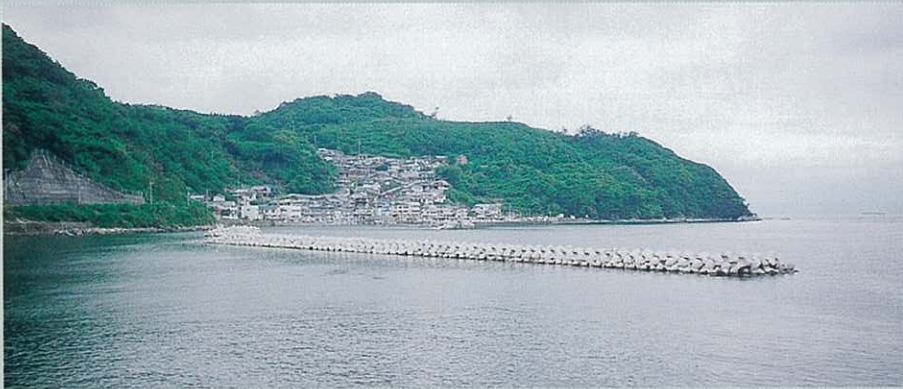
和歌山県 下津港湾事務所 下津港 離岸堤(2層被覆)
