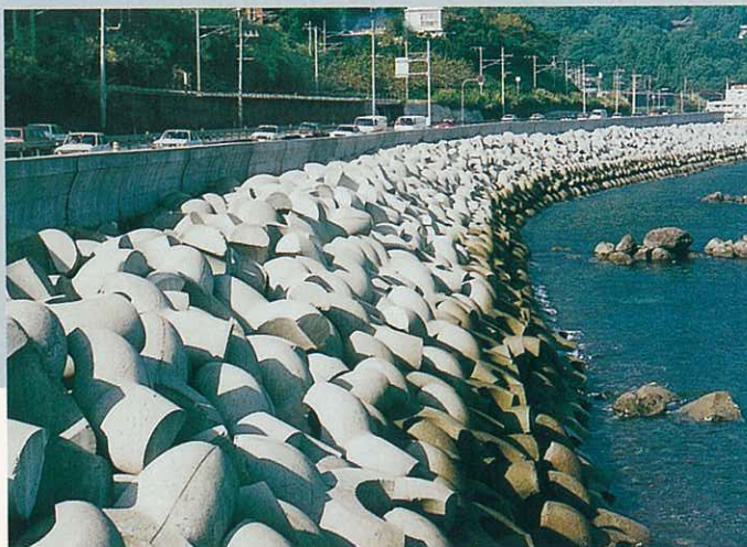
九州地方整備局 大分工事事務所 別大国道4ton 消波工
