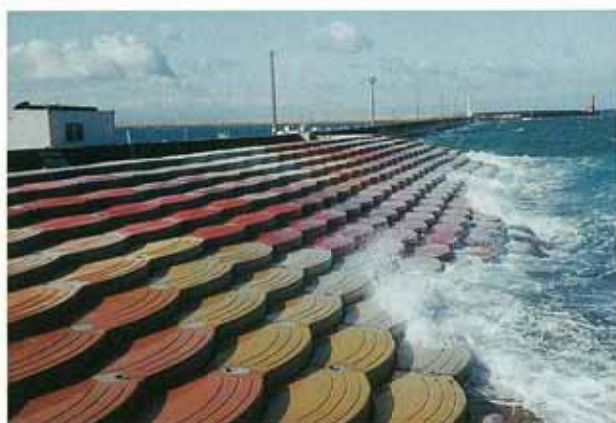
愛知県 豊橋土木事務所 伊良湖港海岸(3割勾配)
