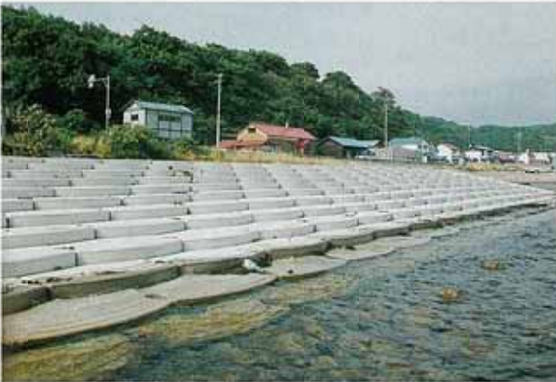
北海道 小樽土木現業所 掘株海岸(5割勾配)
