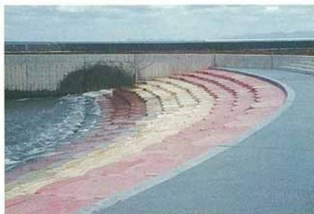
青森県 西北地方漁港事務所 終ヶ沢漁港(4割勾配)
