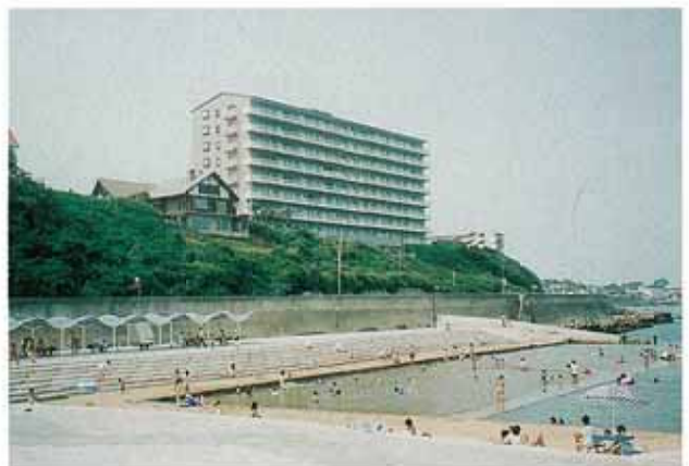
茨城県 ひたちなか市役所 那珂湊漁港(海水プール)(4割勾配)
