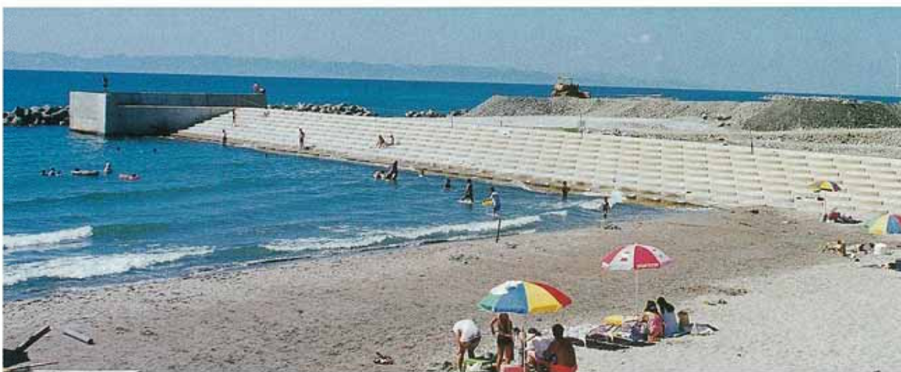
新潟県 巻土木事務所 間瀬漁港(3割勾配)
