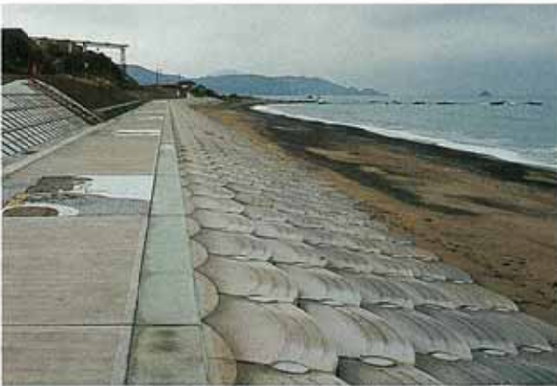
島根県 益田土木事務所 持石海岸(3割勾配)
