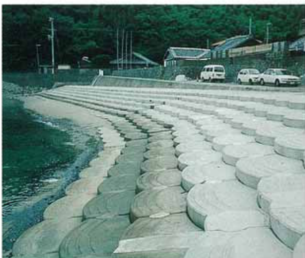
和歌山県 御坊土木事務所 由良港(柏地内) (3割勾配)
