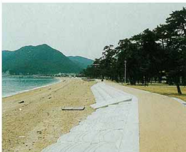
岡山県 玉野建設事務所 渋川海岸(3割勾配)
