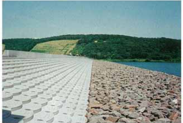
青森県 むつ小川原港管理事務所 むつ小川原港(鷹架沼防潮堤)(3割勾配)
