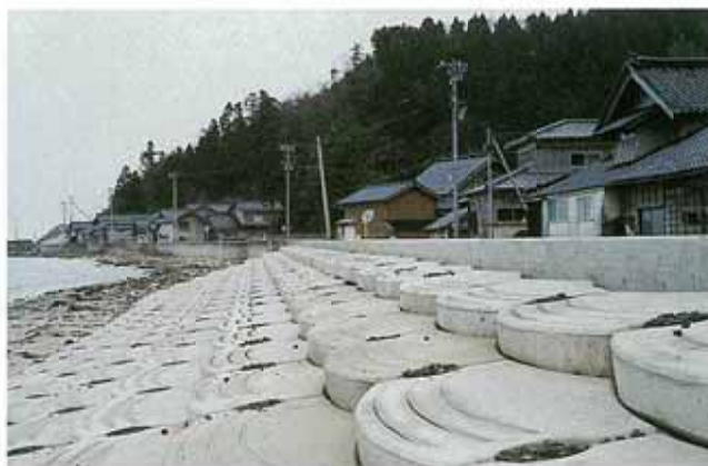
石川県 七尾土木事務所 大野木海岸(3割勾配)
