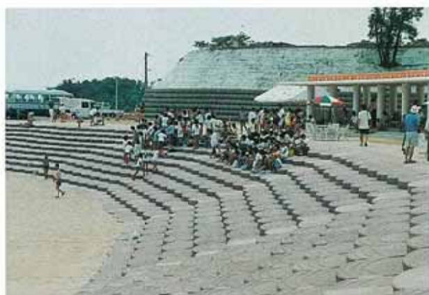
佐賀県 鹿島土木事務所 大浦港海岸(白浜地区)(3割勾配)
