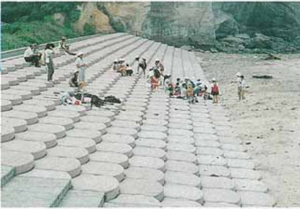
茨城県 高萩土木事務所 高戸浜海岸(3割勾配)
