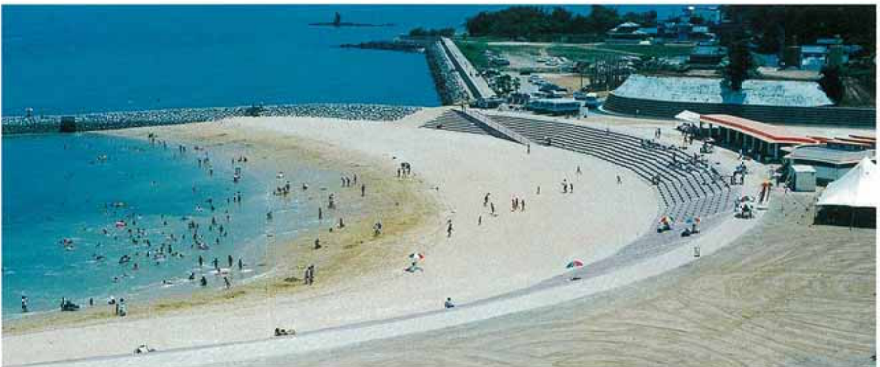
佐賀県 鹿島土木事務所 大浦港海岸(白浜地区) (3割勾配)
