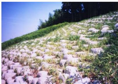
**パネルウッド工法** (木系根固工)
