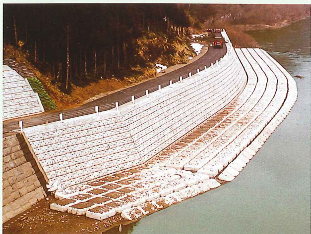
東北地方整備局 能代河川国道事務所 2ton型(基本タイプ)43型 「米代川・小繋護岸工事」
