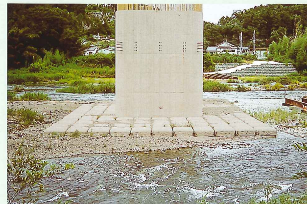
奈良県 吉野土木事務所 3ton型(基本タイプ) 「馬佐・岩森線道路改築(橋架)工事」
