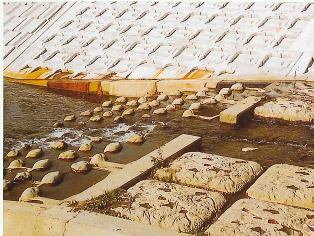
北海道 札幌土木現業所 2ton型(基本タイプ)43型 「ベンケ歌志内川河川改修工事」
