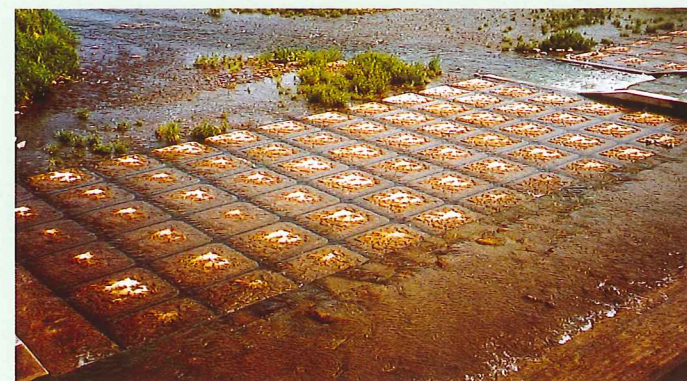
長崎県 諫早土木事務所 「萱瀬ダム水位観測用帯工設置工事」
