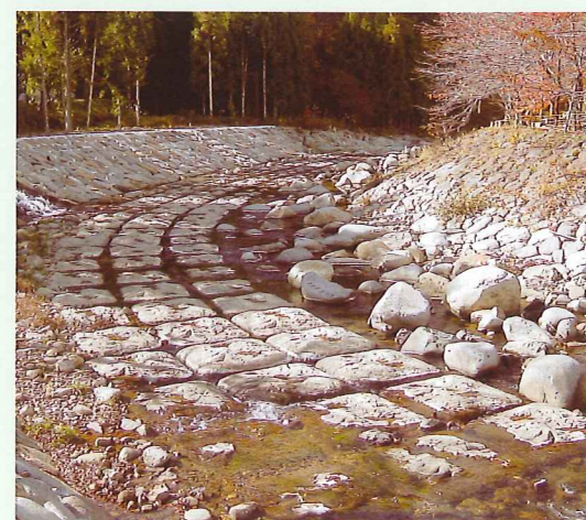
岐阜県 八幡建設事務所 6ton型(基本タイプ) 「長良川河川災害復旧事業工事」
