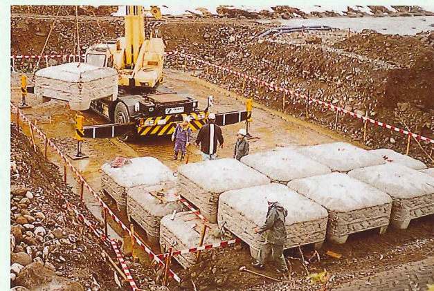
新潟県 糸魚川土木事務所 6ton型(積上タイプ) 「海川小規模河川改修工事」
