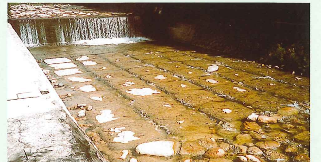
新潟県 新発田土木事務所 4ton型(基本タイプ) 「安野川河川災害復旧工事」
