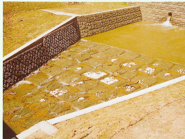
北海道 室蘭土木現業所 2ton型(基本タイプ)43型 「久保内川砂防工事」
