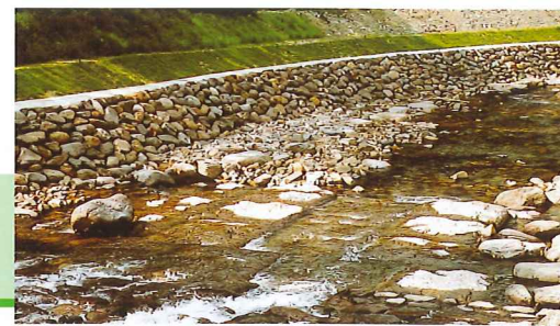
福島県 喜多方建設事務所 6ton型(基本タイプ) 「田付川河川災害復旧工事」
