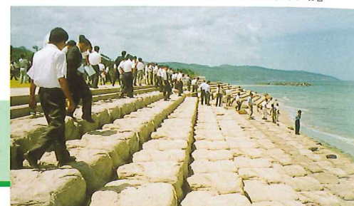
島根県 出雲土木建築事務所 「岐久海岸浸食対策工事」 旧2ton型(階段タイプ)
