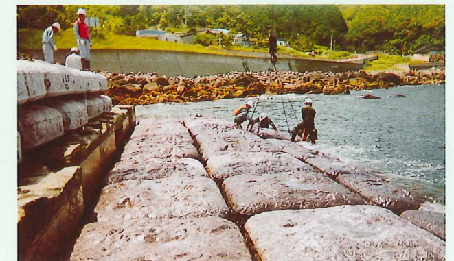
北海道 函館土木現業所 「恵山岬道単局改良工事」
