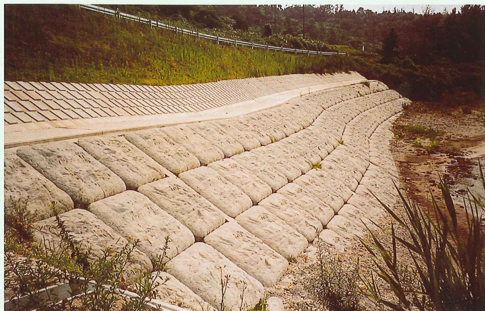
石川県 珠洲土木事務所 「大谷・狼煙・飯田線緊急地方道路整備災害防除工事」
