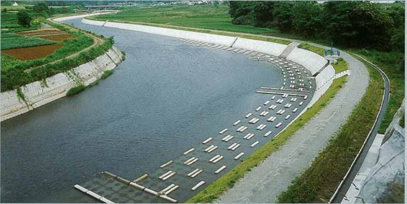
福島県 県南建設事務所 久慈川 2 ton 根固・水制工
