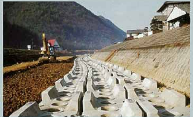
岡山県 東備地方振興局 金剛川 2 ton 根固工
