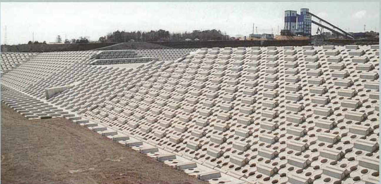
九州地方整備局 雲仙復興事務所 水無川 3 ton (法覆工)
