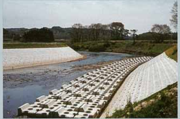
福島県 県南建設事務所 社川 2 ton
