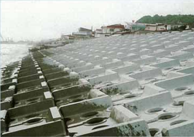
北海道 室蘭土木現業所 三石本町海岸 2 ton・3 ton
