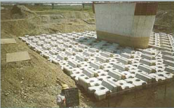
兵庫県 伊丹市役所 猪名川 2 ton 橋脚根固工
