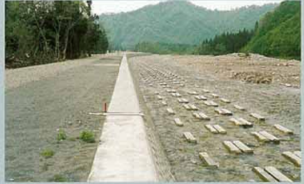
北陸地方整備局 飯豊山系砂防事務所 荒川 4 ton 根固・護床工
