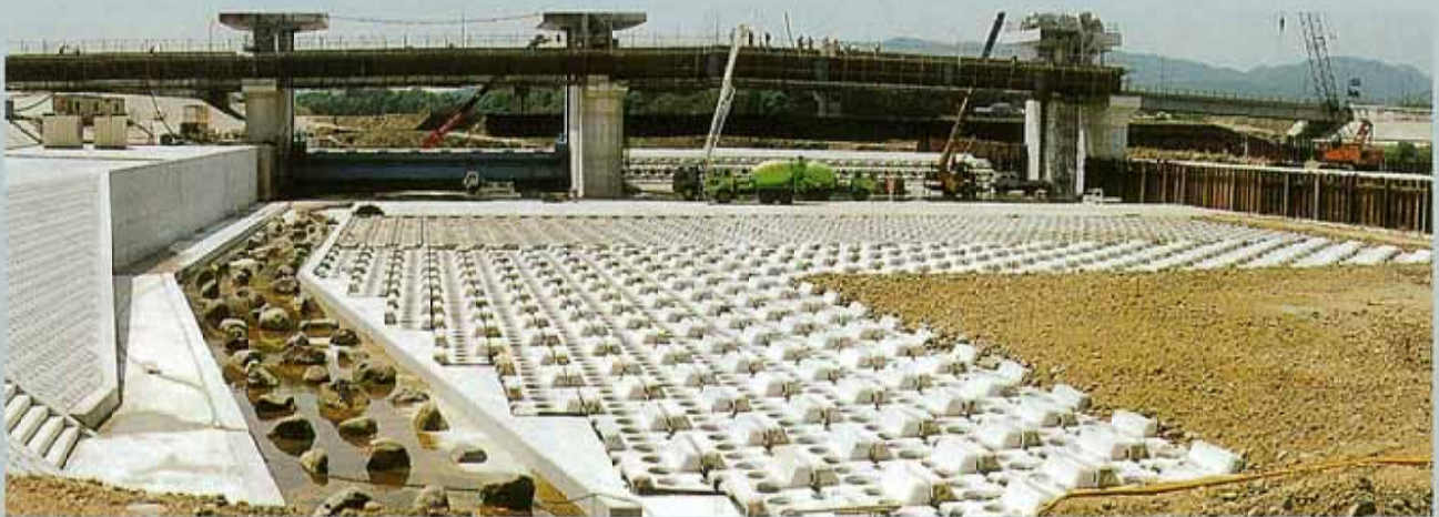
九州地方整備局 大分河川国道事務所 山国川 2ton 護床工
