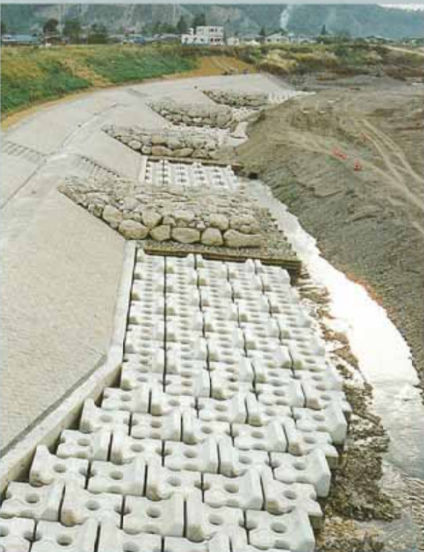
北陸地方整備局 千曲川河川事務所 千曲川 3 ton 根固工
