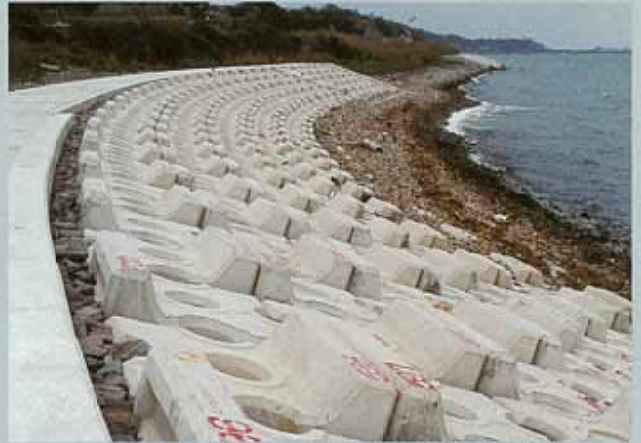
鳥取県 米子土木事務所 名和海岸 2 ton
