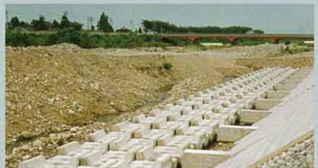
富山県 入善土木事務所 小川 5 ton 根固工
