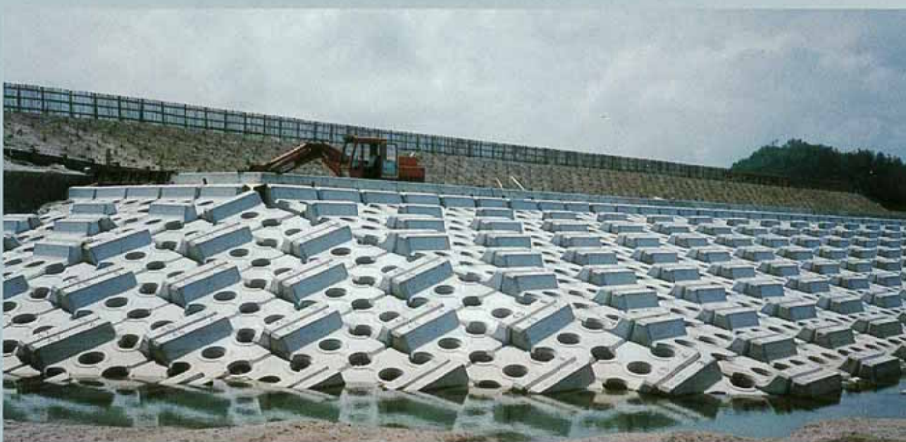
鳥取県 鳥取土木事務所 賀露海岸 2 ton
