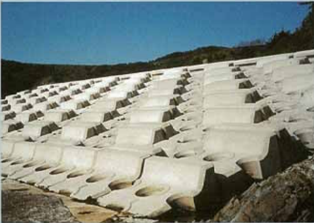
新潟県 相川土木事務所 大浦海岸 4 ton
