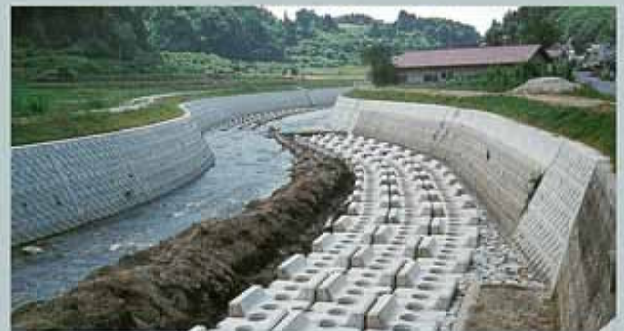
福島県 県中建設事務所 移川 2 ton 根固・水制工
