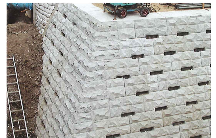
弊社化粧型枠NPストーン併用例 福島県「境掘川」
