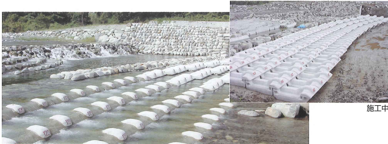
関東地方整備局 富士川砂防工事事務所 「大武川床固工事」 6t
