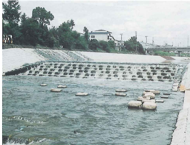
大阪府 鳳土木事務所 「禎尾川」 2t
