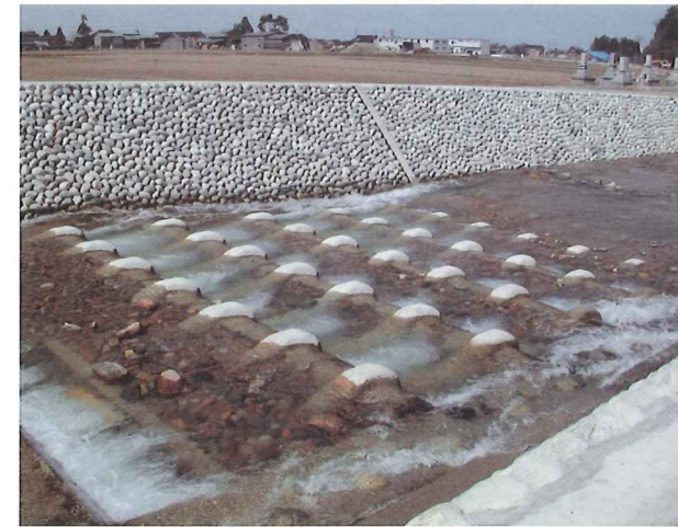
富山県 入善土木事務所 「舟川」 4t
