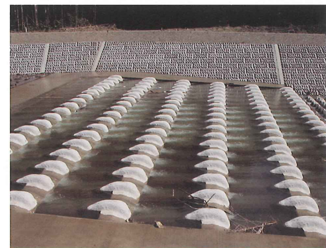
栃木県 栃木土木事務所 「永野川」 4t
