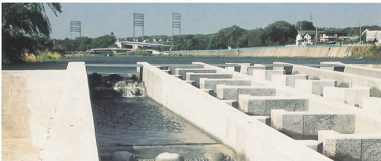
流況に変化を持たせる為、ブロックを傾けて敷設している。
